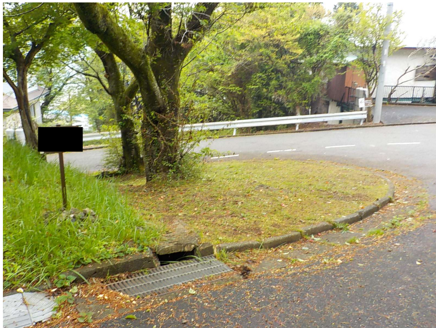
南側道路より撮影 完了
