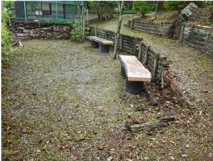
中央ベンチ付近 完了
