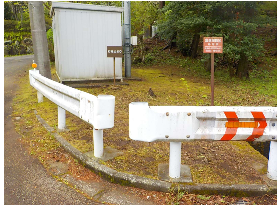
防災倉庫西側 完了
