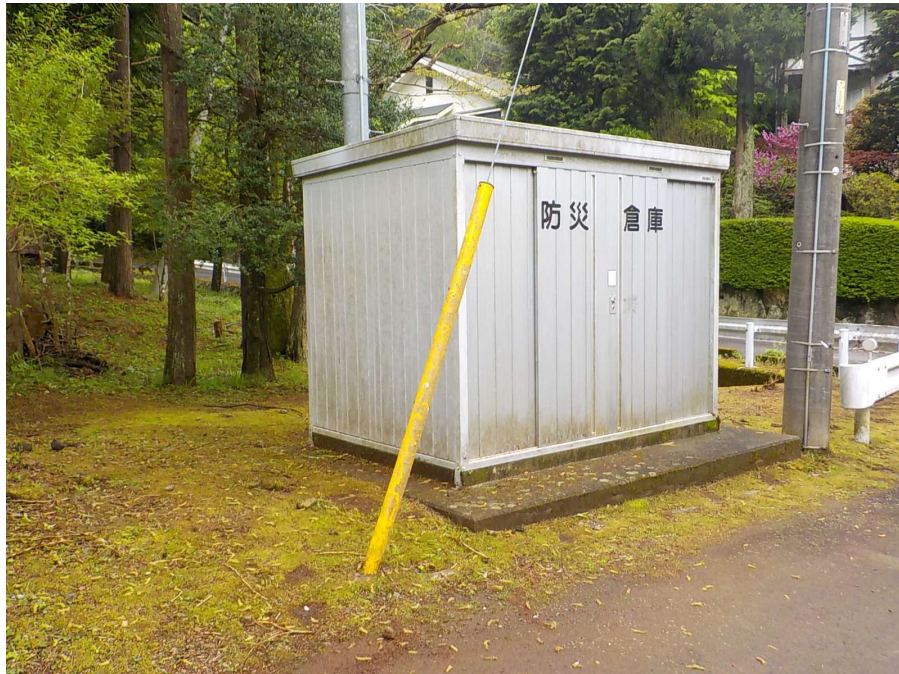
防災倉庫東側 完了
