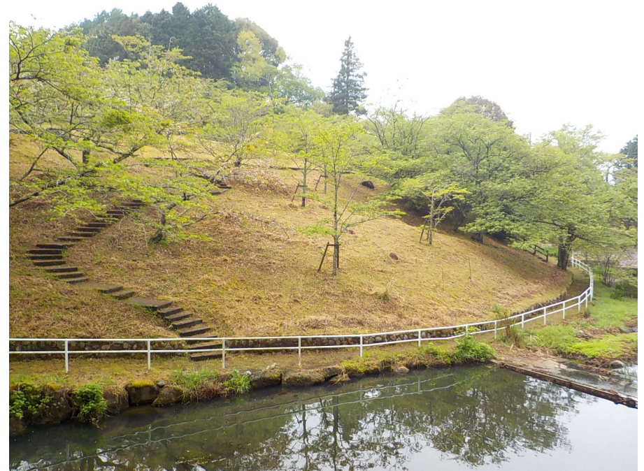
池側斜面 完了
